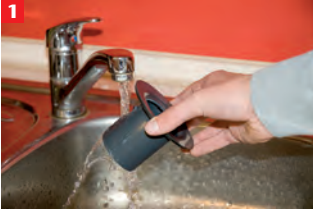
1 Den Geruchsverschluss unter Wasser säubern
