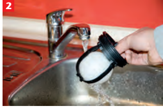
2 Rückstaeinheit und Dichtungen gründlich unter fließendem Wasser reinigen
