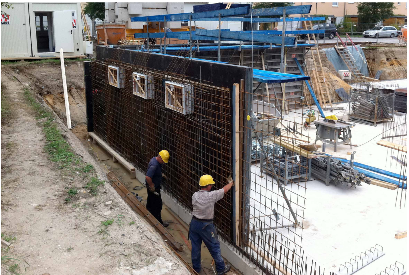
Deutlich zu erkennen: Die ACO Therm® Leibungsfenster wurden vor dem Herstellen der Kellerwand an der Schalwand befestigt.
