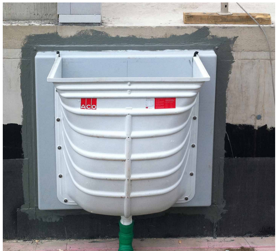
Der fertig installierte Lichtschacht auf dem Montageelement ACO Therm® Block
