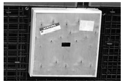
Die Holzaussteifungen müssen während der Einbauphase montiert bleiben
